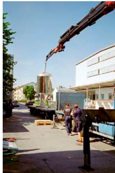
Delivery of CCT from Kungsholmen to Fruängskällan
